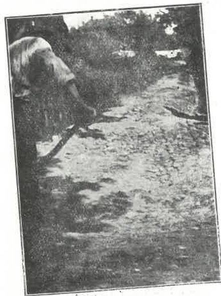
Fot. 4. Wyrte przez ścieki rynny na posesji Nr. 13, gdzie również napotkano na obfite ślady substancji oleistych.
