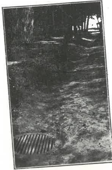
Fot. 3. Kratka ściekowa w rynsztoku w pobliżu bramy posesji Nr. 13, z której ścieki wierzchem do niej spływają, gdzie napotkano na obfite ślady substancji oleistych.
